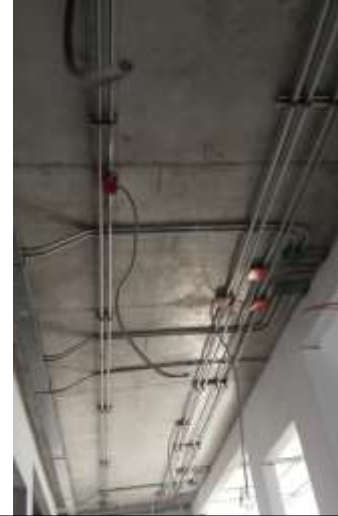
ร้อยสายไฟฟ้างานระบบไฟฟ้า ชั้น ๒
