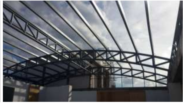
โครงเหล็กหลังคา ชั้น ๕
