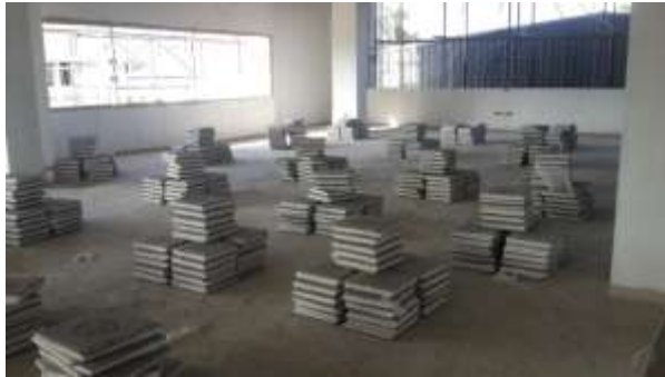
เตรียมปูพื้นหินขัด ชั้น ๓
